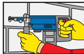
Realizar la perforación con el diámetro y profundidad requeridos. El diámetro de la perforación debe ser de acuerdo al diámetro del ancla (Ver diámetros recomendados en tablas).
